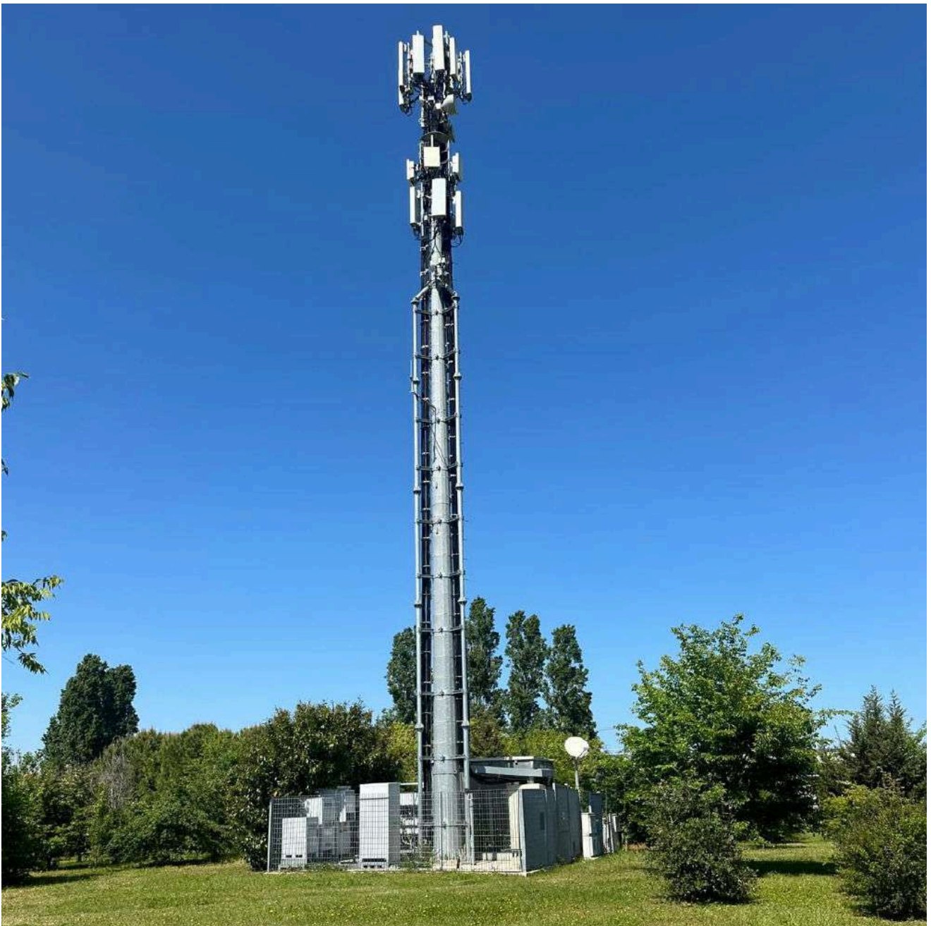
Fig. 19: SRB già esistente a Villa Torlonia
